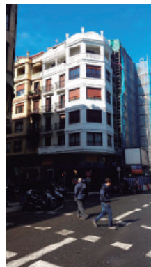
Esquina mirador con sus molduras y paños rehabilitados con sistema SATE y acabados con morteros de alta decoración de imitación marmórea. Fuente: Kursaal Rehabilitaciones, 2016.
