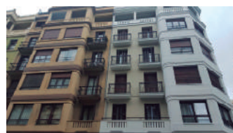
Comparativa entre la parte sin rehabilitar (izquierda) y parte rehabilitada (derecha). Esquina del mirador de hormigón armado rehabilitada. Fuente: Kursaal Rehabilitaciones, 2016.
