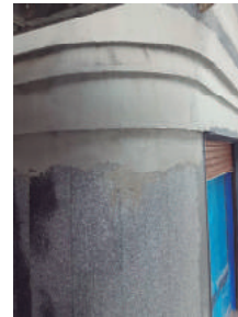
Ejecución de molduras con aislamiento térmico y máquina de corte específica. Fuente: Kursaal Rehabilitaciones, 2016.
