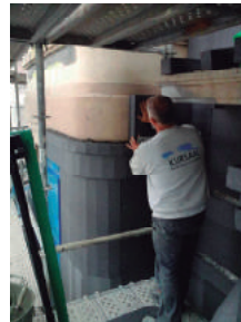
Ejecución de molduras con aislamiento térmico y máquina de corte específica. Fuente: Kursaal Rehabilitaciones, 2016.
