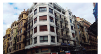
Comparativa entre la parte sin rehabilitar (izquierda) y parte rehabilitada (derecha). Esquina del mirador de hormigón armado rehabilitada. Fuente: Kursaal Rehabilitaciones, 2016.
