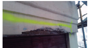
Molduras existentes y patologías antes de la rehabilitación. Fuente: Kursaal Rehabilitaciones, 2015.
