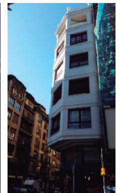
Esquina mirador con sus molduras y paños rehabilitados con sistema SATE y acabados con morteros de alta decoración de imitación marmórea. Fuente: Kursaal Rehabilitaciones, 2016.
