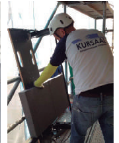
Ejecución de molduras con aislamiento térmico y máquina de corte específica. Fuente: Kursaal Rehabilitaciones, 2016.
